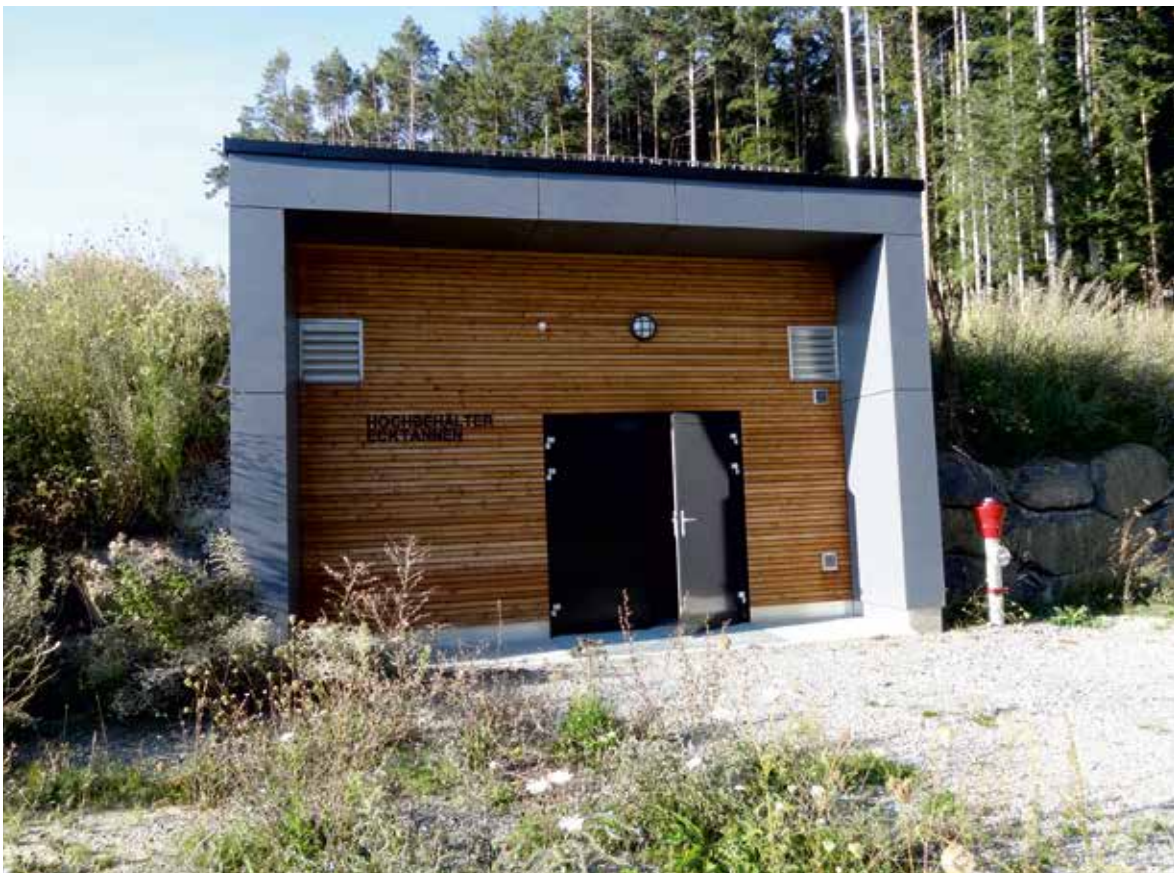
Hochbehälter Ecktannen, Göfis (Foto: Abt. Wasserwirtschaft)
