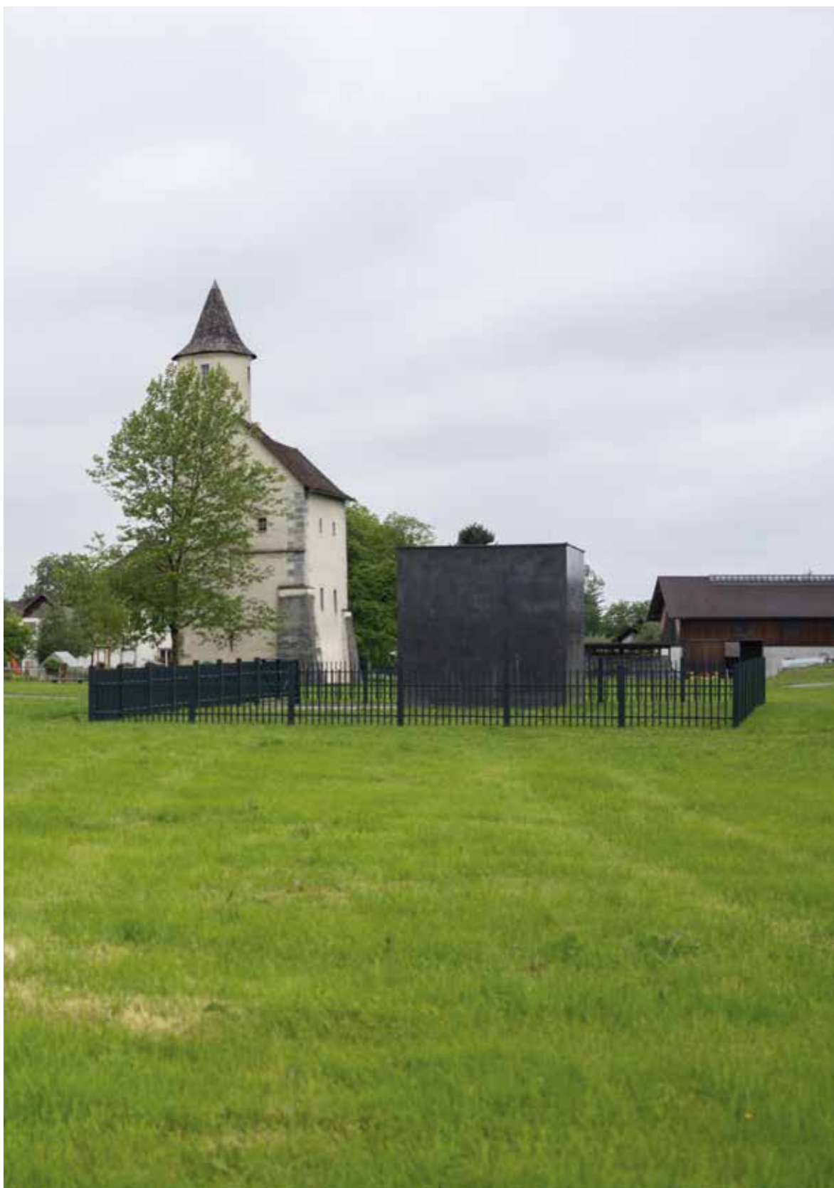
Pumpwerk Mittelweiherburg in Hard, Brunnengebäude und Schutzzone I (2018, Foto: Abt. Wasserwirtschaft)
