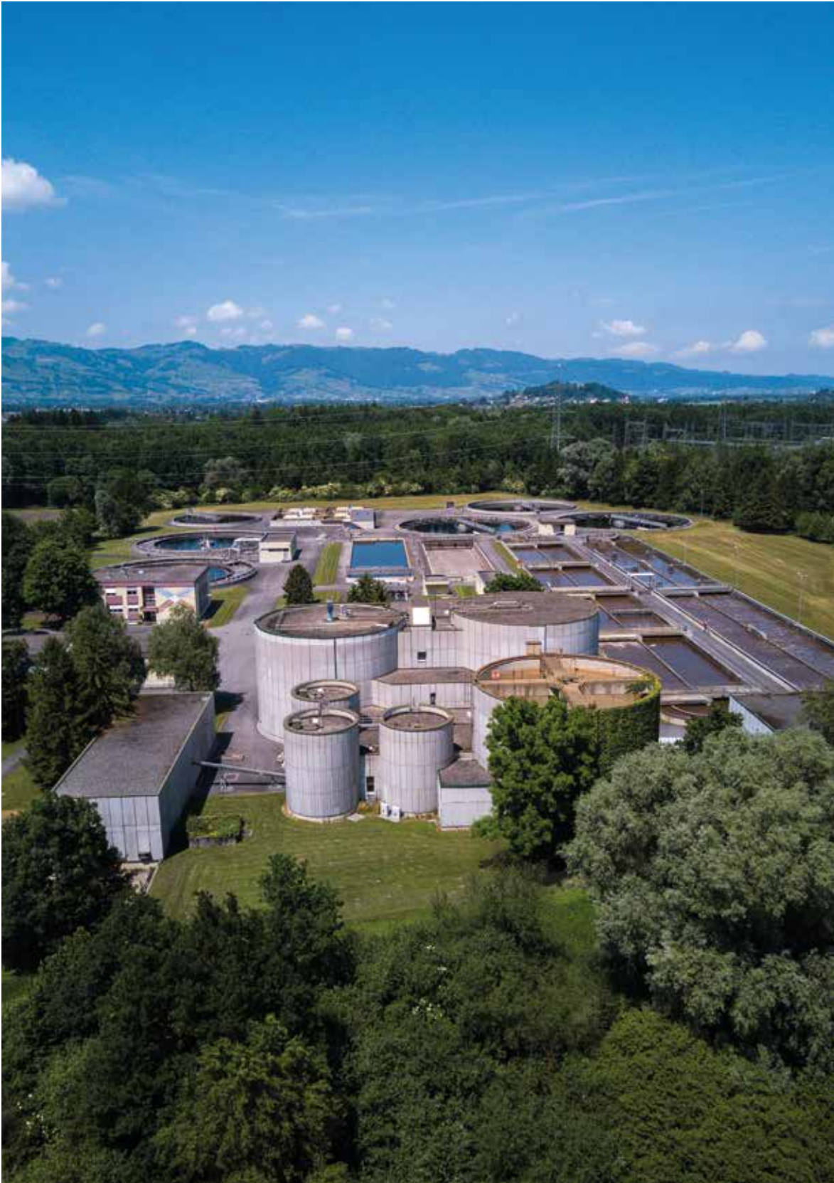
Luftbildaufnahme der ARA Meiningen (Foto: M. Mayer, 2017)
