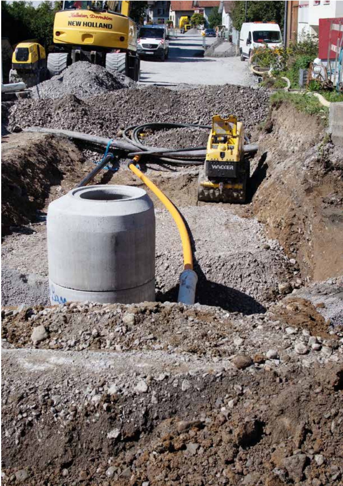
Kanalbau in Dornbirn, 2019 (Foto: Abt. Wasserwirtschaft)
