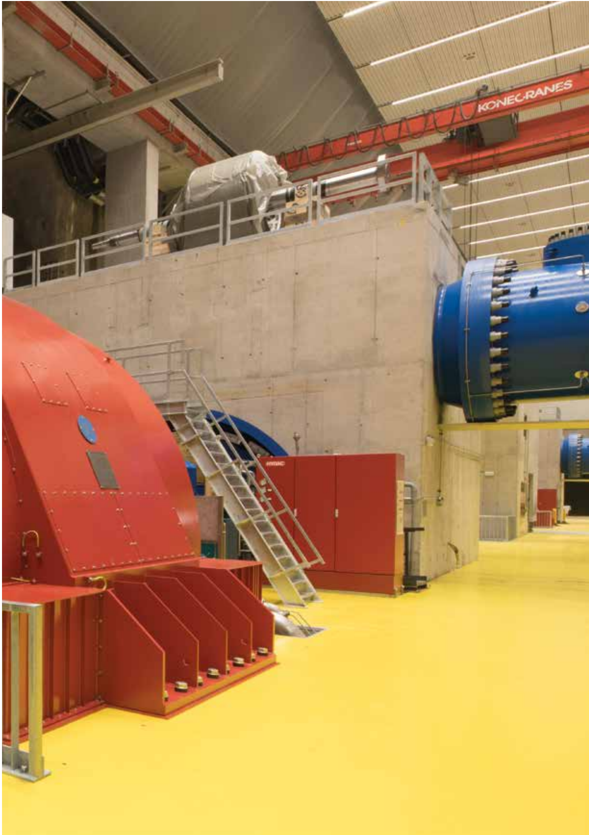
Kraftwerkskaverne Obervermuntwerk II (Quelle: illwerke vkw, Patrick Säly)
